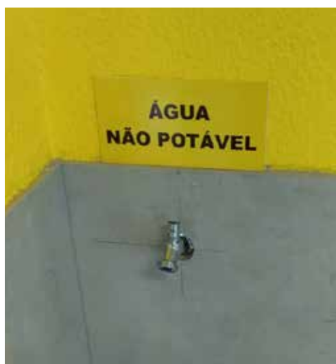
Foto 9.2. Identificação dos pontos de utilização de água não potável
